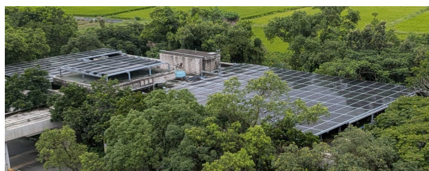
圖：本院屋頂太陽能光電板建置現況
